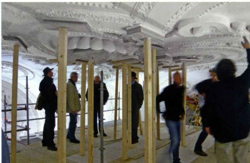
1 Gewölbeuntersicht mit Abstützungen während eines Ortstermins.
